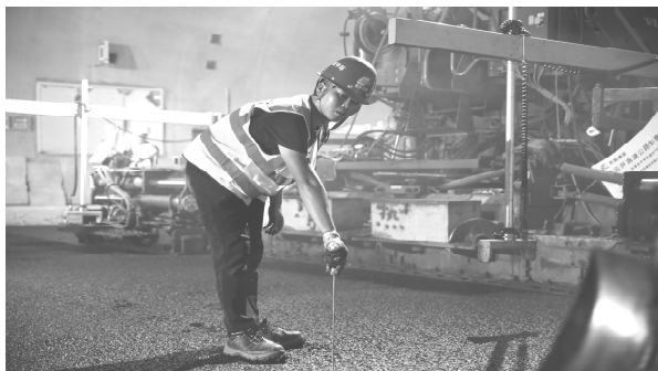
冷政在测量铺沥青路面平整度
