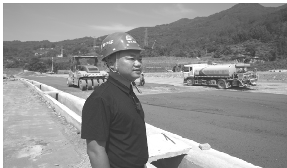
杨皓在查看水稳层路面施工
